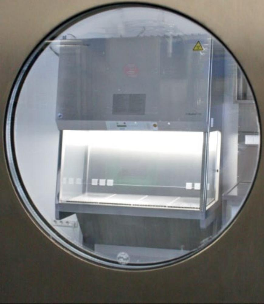
**Die Geräteausstattung eines Sicherheitslabors ist technisch anspruchsvoll und von höchster Qualität. Eine besondere Bedeutung für den Schutz der Mitarbeiter kommt hier den Sicherheitswerkbanken zu. Diese verhindern den Ausbruch von Krankheitserregern, die bei der Handhabung in der Sicherheitswerkbank von Proben zwangsläufig freigesetzt werden.**
